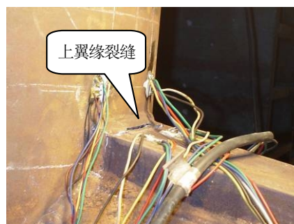
图5 腰部节点 HW1 破坏
